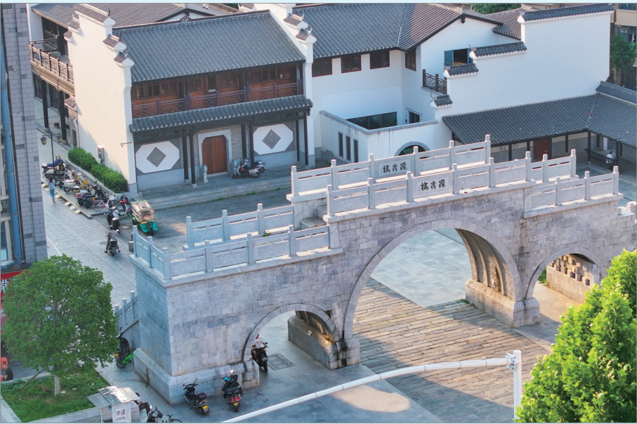
溁湾镇，西出长沙第一站，因水陆交通优势成就繁华古镇。
