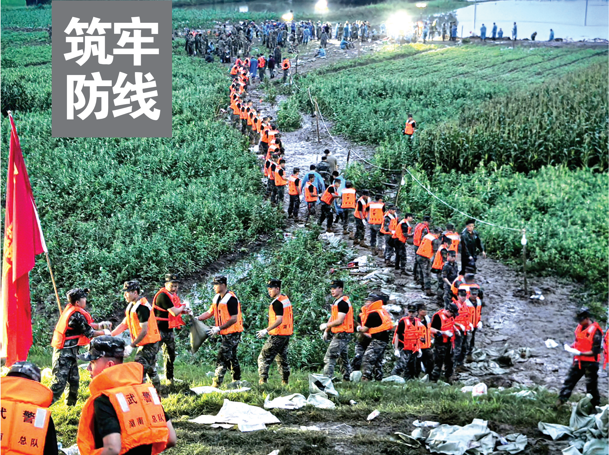
6月22日，澧县，武警官兵在抢险现场搬运沙袋。澧县澧水大堤21日晚出现一处管涌群，经应急处置，目前险情可控。图/凌霄晴
