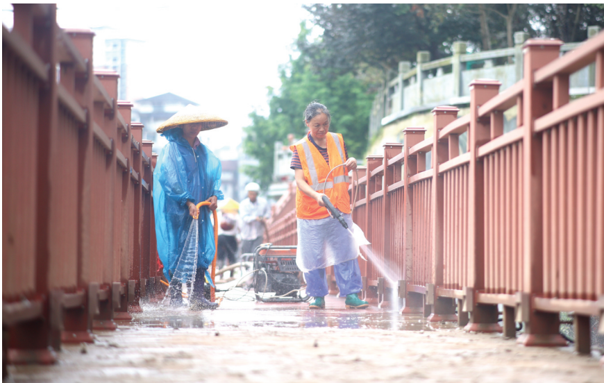
6月23日,怀化市通道侗族自治县双江河沿河步道,工人在清理淤泥。图/通讯员李尚引
