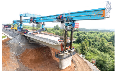
6月25日拍摄的邵永高铁柘刺坪特大桥架梁施工现场（无人机照片）。图/新华社
