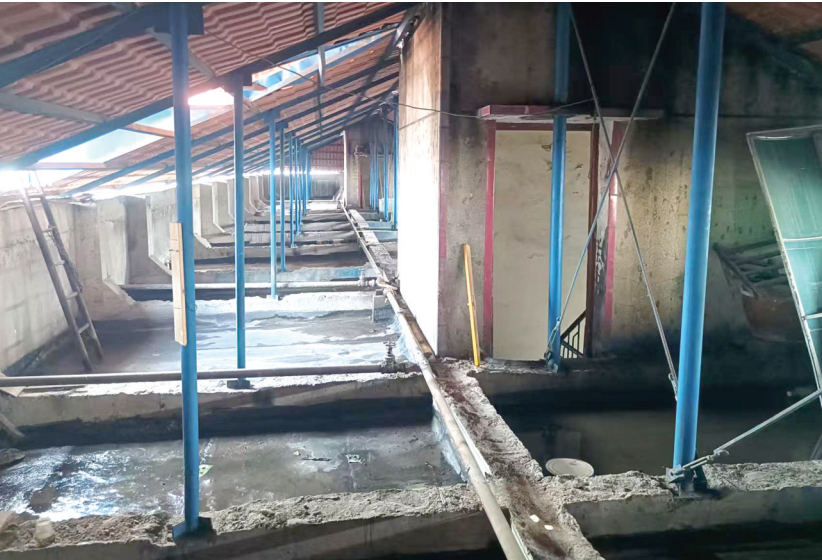
该小区雨棚。图/记者於广毅
