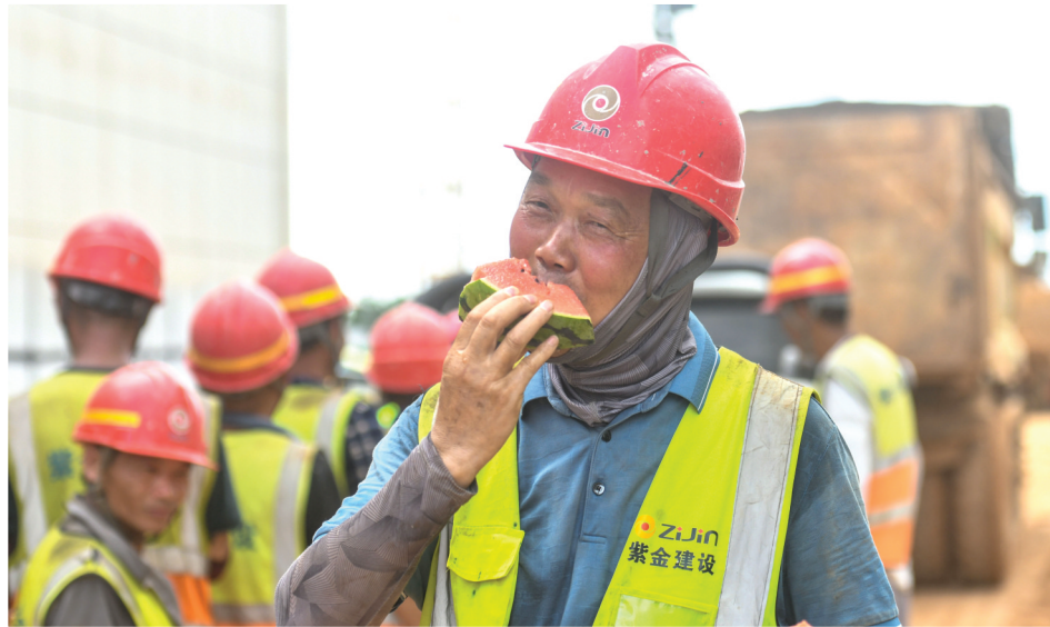
6月30日,永州市道县蚣坝镇湖南紫金锂多金属新材料有限公司项目建设现场。连日来,当地气温持续偏高,建设单位采取“错峰施工”模式,同时为一线工人发放包含防暑药品、清凉饮料等物资的“清凉礼包”。图/通讯员蒋克青
