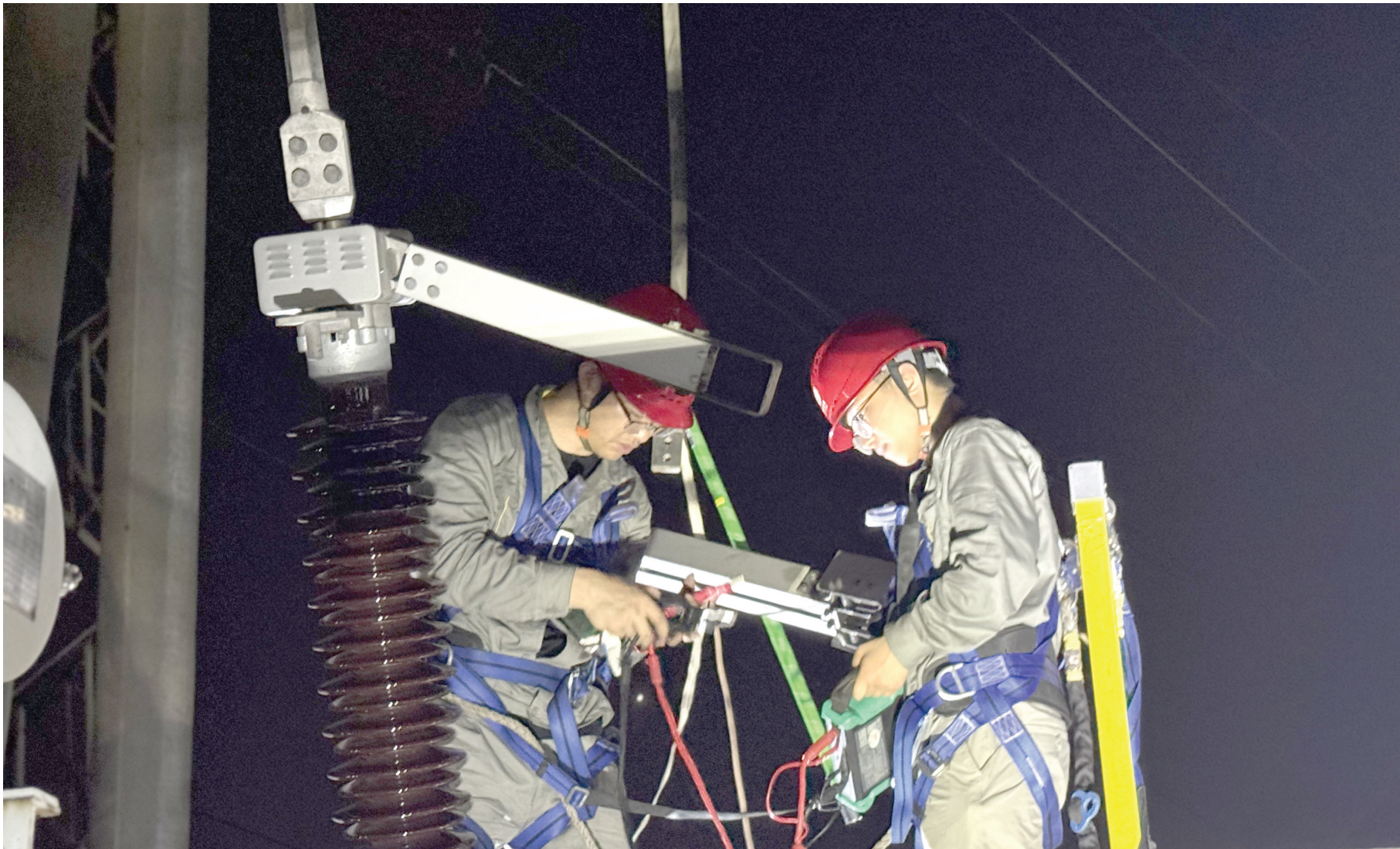
国网长沙供电公司变电检修人员在220千伏学士桥变开展设备消缺作业。图/通讯员汤真
