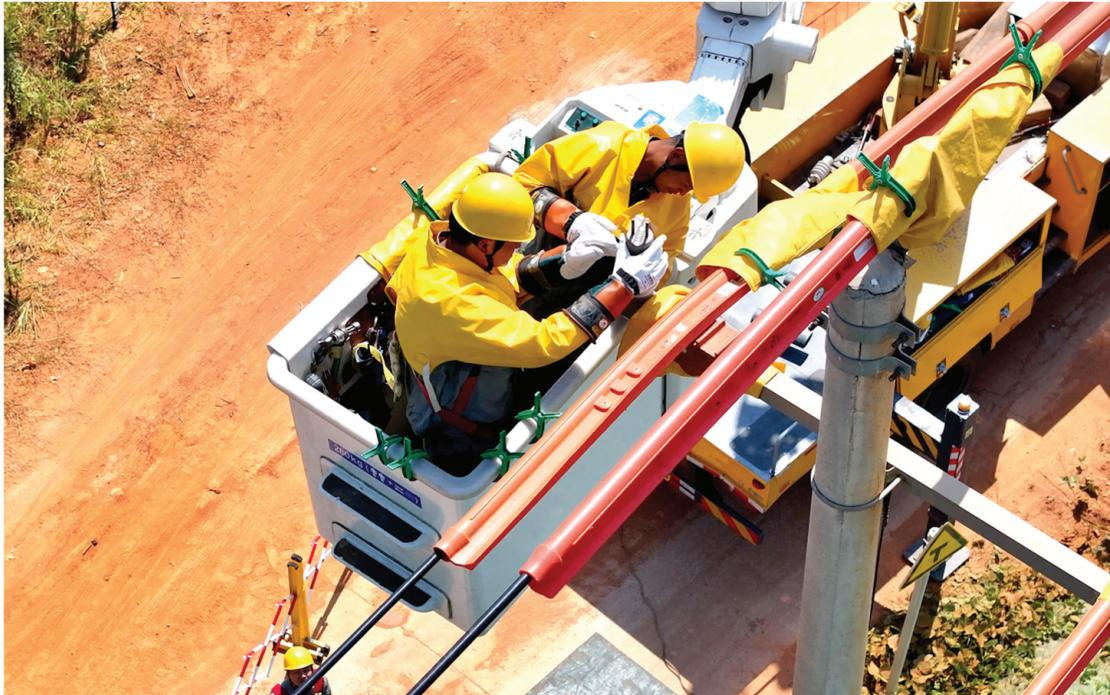
国网湖南电力工作人员在湘潭市10千伏响环线开展带电作业,快速消除线路瓷瓶隐患。组图/国网湖南电力提供
