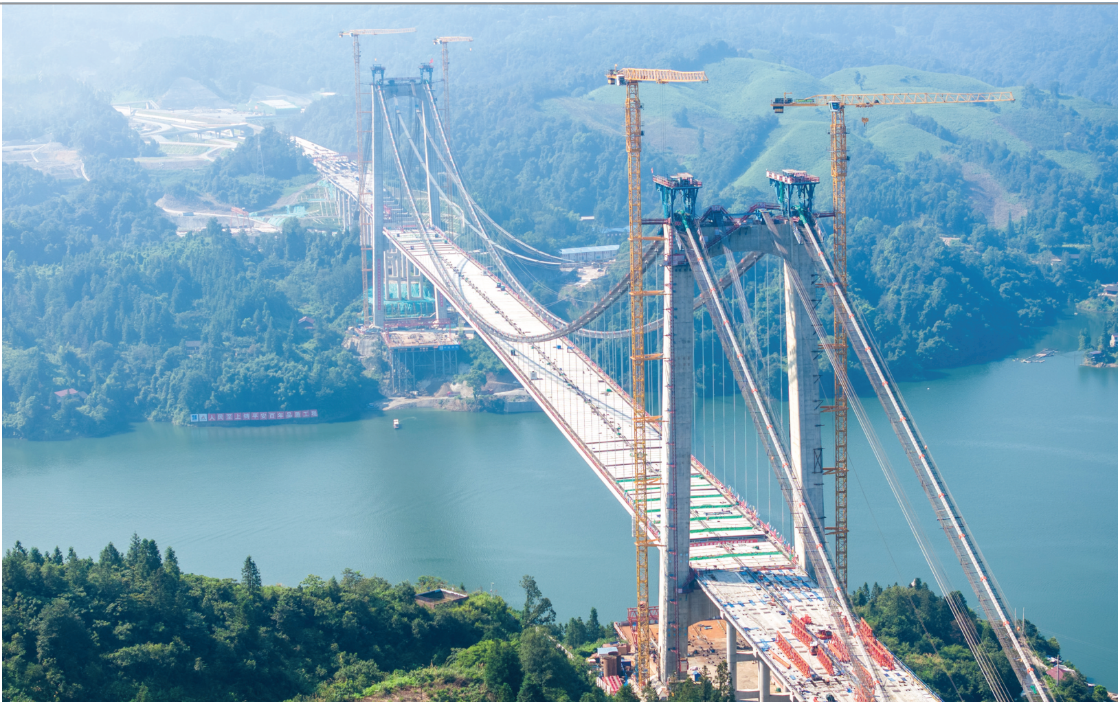
◀这是8月3日在怀化市沅陵县拍摄的施工中的张官高速洞庭溪沅水特大桥(无人机照片)。
