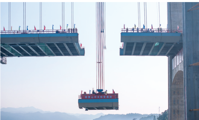
8月3日,在张官高速洞庭溪沅水特大桥施工现场,一块钢混结合梁在被缓缓提升(无人机照片)。 组图/新华社
