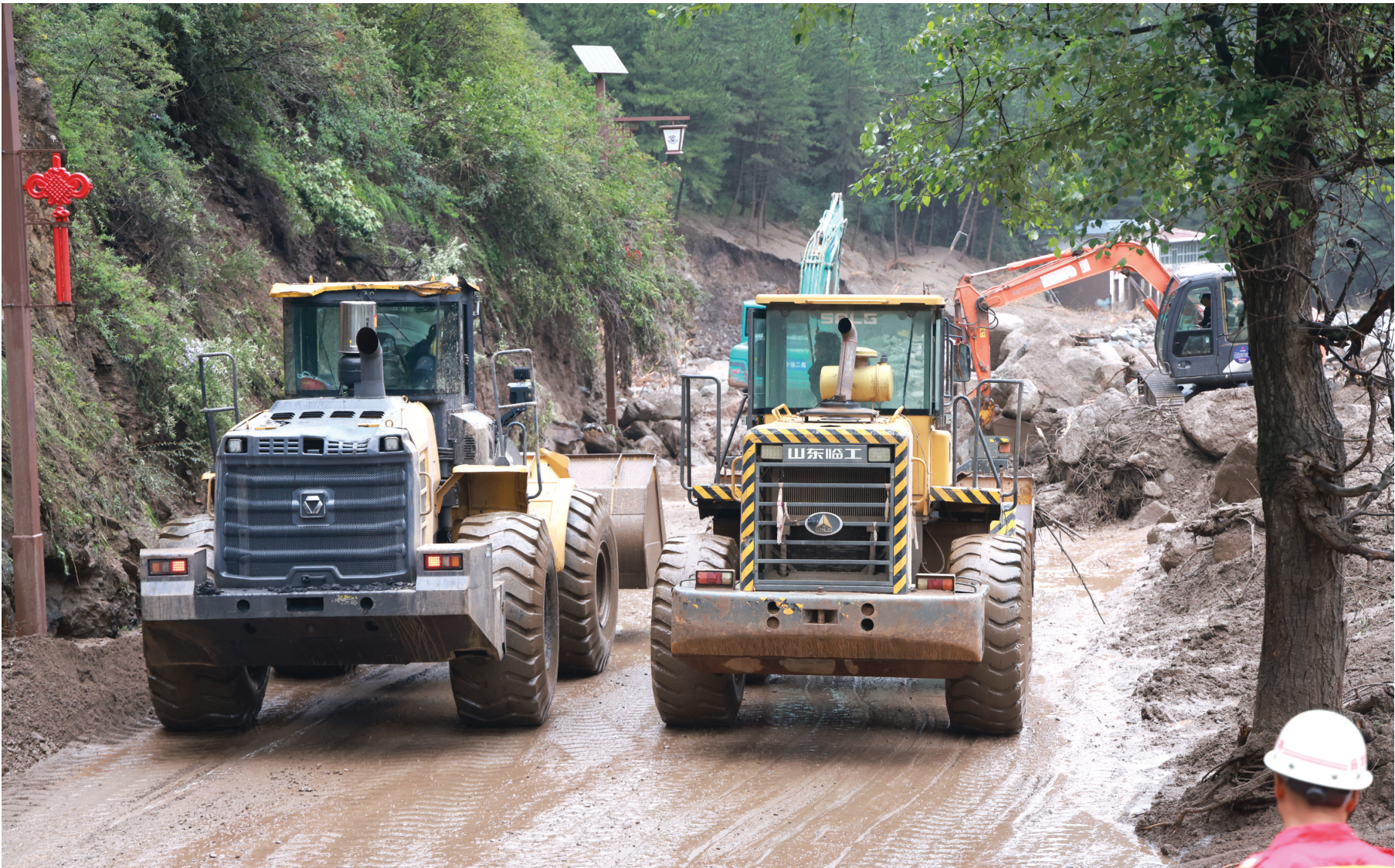
8月8日,救援人员在榆中县马坡乡山洪灾害现场抢修中断道路。图/新华社
