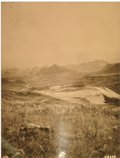
为了确保前线战略通道畅通,对京滇公路进行降坡改道。
