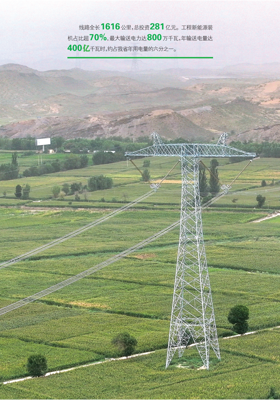
这是8月20日拍摄的“宁电入湘”工程直流输电线路(无人机照片)。组图/新华社
