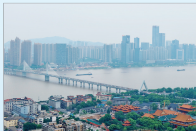
▲银盆岭大桥,近处是开福寺,江对岸是湖南金融中心。
