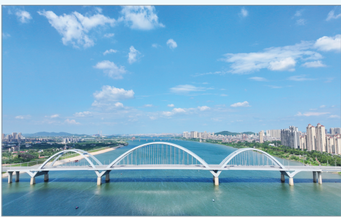
下摄司大桥,湘江上最年轻的桥之一。
