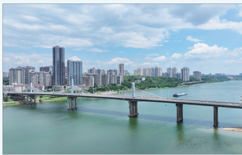
株洲天元大桥。
