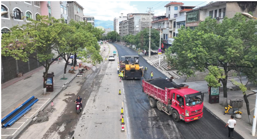
江华城区主干道“白改黑”改造工程进入收尾阶段。图/央视新闻
