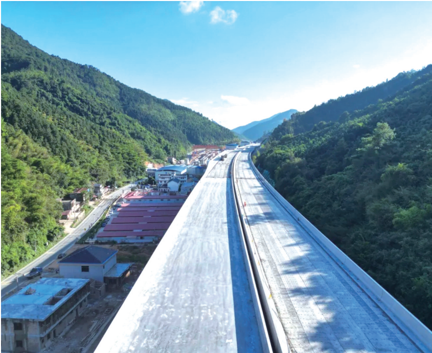
零道高速公路建设现场。图/湖南交通运输微信公众号
