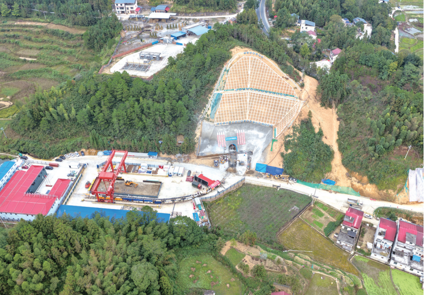
湖南双牌天子山抽水蓄能电站首台隧道掘进机“天子山号”顺利始发。图/受访者提供
