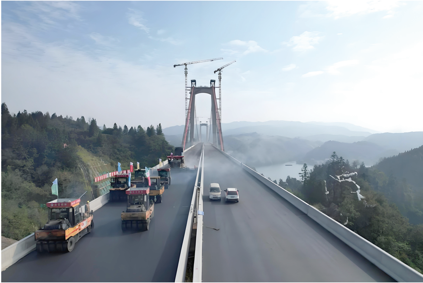
16日,洞庭溇沅水特大桥沥青桥面摊铺施工圆满收官。图/受访者提供
